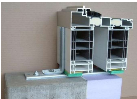
Ilustracja 61: Skręcić kątownik łączący z elementem i wspornikiem. Osadzić drugi kołek o dużej wytrzymałości
