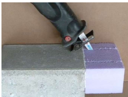
Ilustracja 58: Precyzyjnie wyciąć pozycję zamocowania
