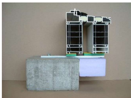
Ilustracja 60: Wyrównać element i oklockować
