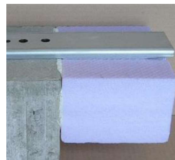
Ilustracja 59: Wprowadzić i zamocować wsporniki (podstawki muszą przylegać do płyty betonowej)
